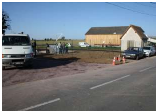
Poste de relevage de la Vallée
