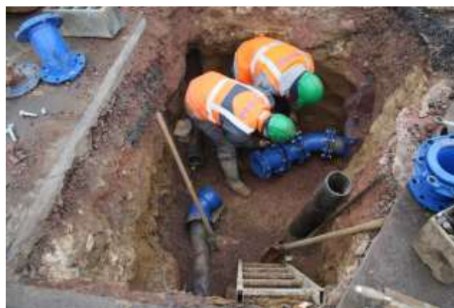
Travaux de raccordement en eau potable
