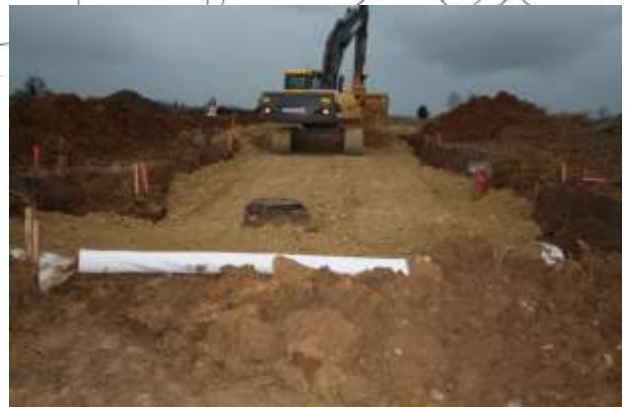
Travaux de voirie : l'encassement
